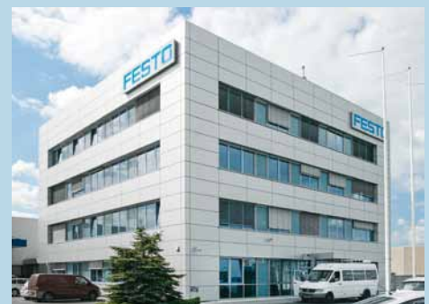
Das Firmengebäude von Festo Polen in Warschau.
