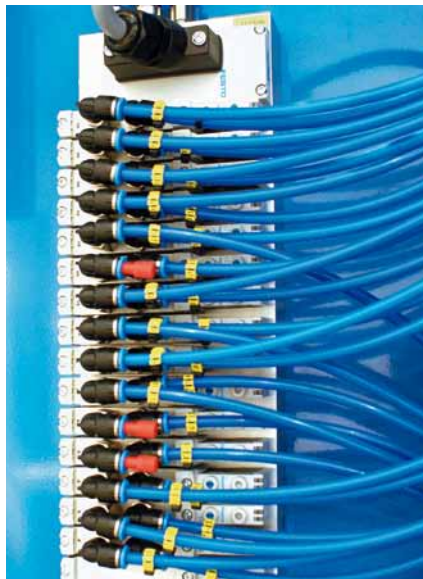
Die universelle Ventilinsel VTUG steuert die Antriebe der gesamten Prozesstechnik an.
